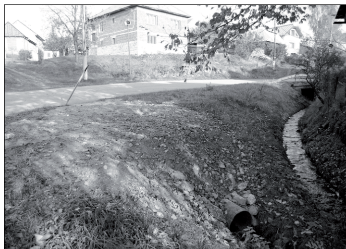
Zakrytie odpadového kanála pred domom č. 256. Na zakrytie boli použité oceľové rúry vymenené pri rekonštrukcii kanalizácie na Fíbeku.
