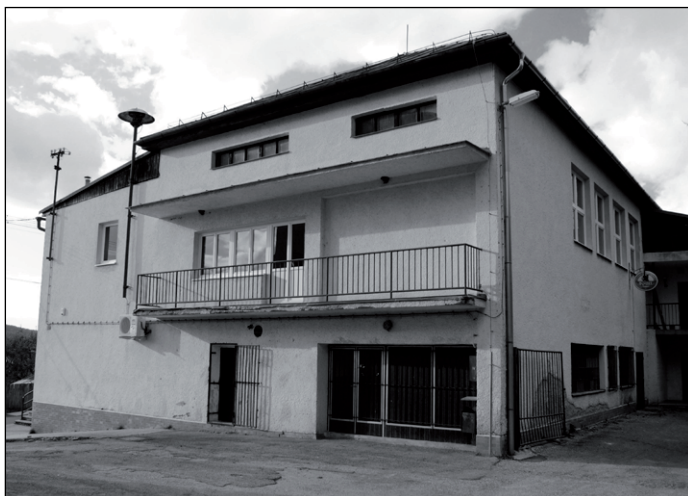
Výmena okien na Kultúrnom dome. Akcia financovaná z prostriedkov Banskobystrického samosprávneho kraja a obecného rozpočtu.
