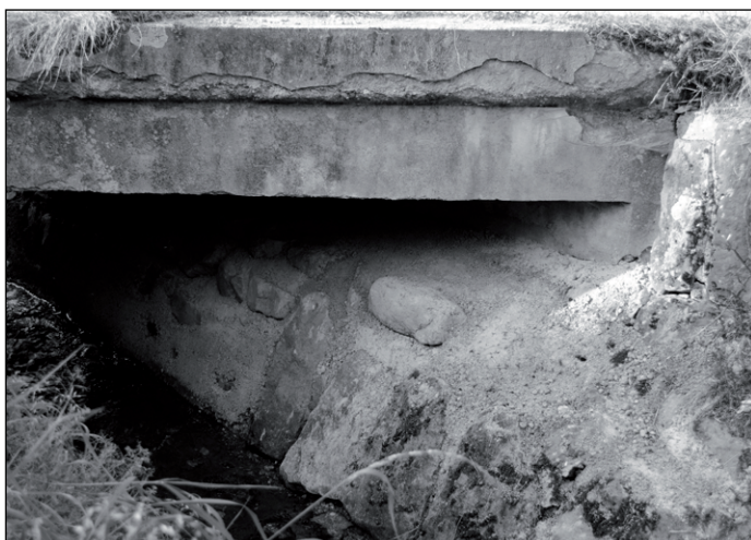
Oprava regulácie potoku. Stabilizácia vymytých kameňov regulácie pod mostom pri dome č. 243. Hrađené z rozpočtu obce.
